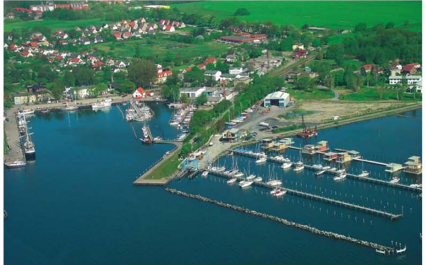
Die Marina „im Jaich“ neben dem Lauterbacher Hafen bietet seit dem Umzug von Prora einen idealen Messestandort für die Rügener Holzmesse. Die Servicehalle als Ausstellungshalle und entsprechende Ausstellungszelte sorgen auf ca. 12.000 m 2 Ausstellungsgelände für ein echtes Messeambiente mit maritimen Charakter.
