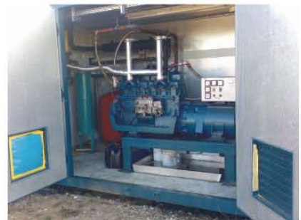
Das Herz eines Holzwerkstoffes, hier ein 30 kw - Stirlingmotor
